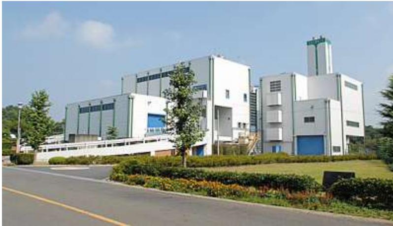
東松山市クリーンセンター（180t/日：昭和 52 年稼働）
