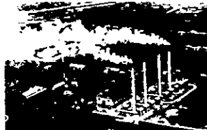
深川塵芥処理工場(1929年竣工) 出典: 東京都清掃事業百年歴史
