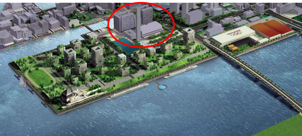
△東京2020オリンピック・パラリンピック招致委員会が国際オリンピック委員会に提出した「立候補ファイル」に掲載された選手村のコンセプト図(円内がごみ処理から回収した電気と熱を選手村に供給する東京23区中央清掃工場)
